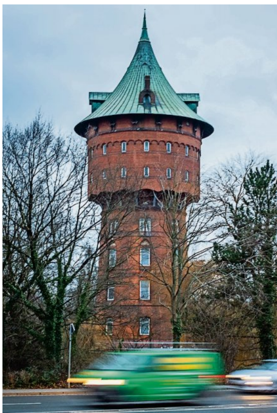
1897 wurde der heute denkmalgeschützte Wasserturm an der Bahnhofstraße 11 in Betrieb genommen. Er ist 48 Meter hoch und verfügt über sieben Etagen.
