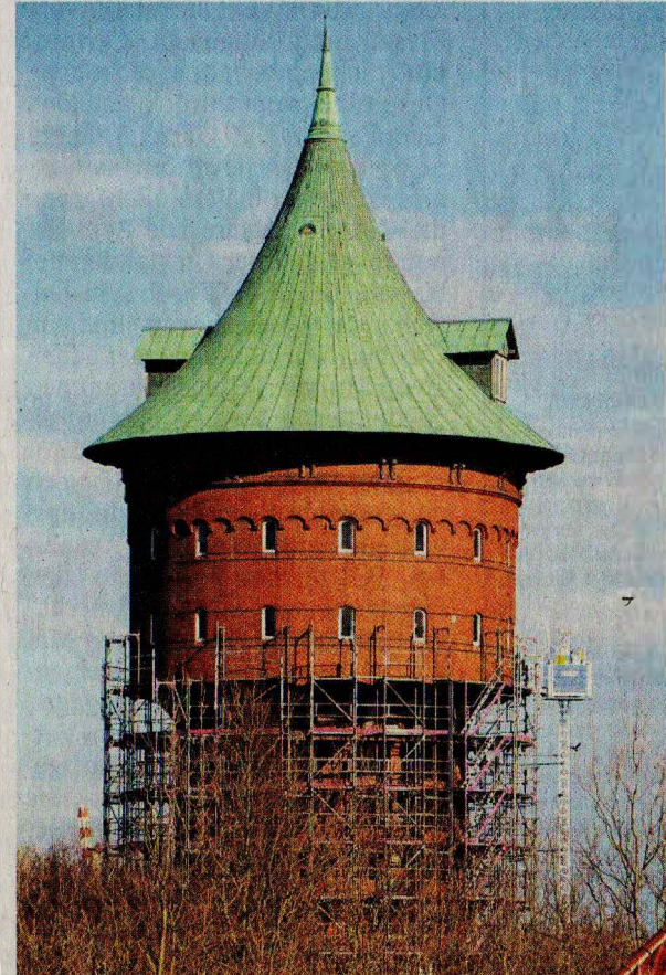
Cuxhavens Wahrzeichen, der Wasserturm, ist eingerüstet. Die Genehmigung zur Sanierung der Außenfassade fehlt allerdings noch.
